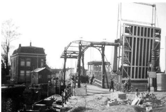
De bouw van de nieuwe basculebrug in 1933, naast de oude klapbrug. Foto vanuit Leiderdorp gezien. (Bron: Beeldbank Gemeente Leiderdorp)
